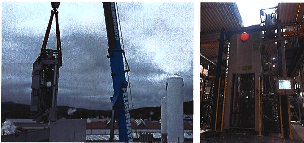
Výkládka 300t lisu SACMI (vľavo), lis po úspešnej inštalácii (vpravo)
