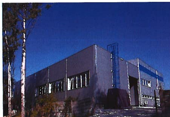
Prístavba k výrobnéj hale – kolaudácia 11/2022
