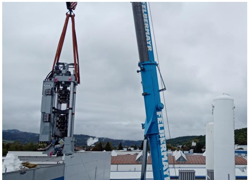
Vykládka výše zobrazeného 300t lisu SACMI, pro jehož umístění do provozu musela být otevřena střecha
