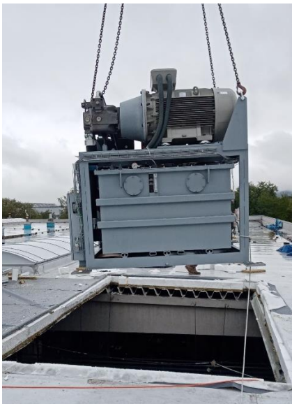
Vykládka výše zobrazeného 300t lisu SACMI, pro jehož umístění do provozu musela být otevřena střecha
